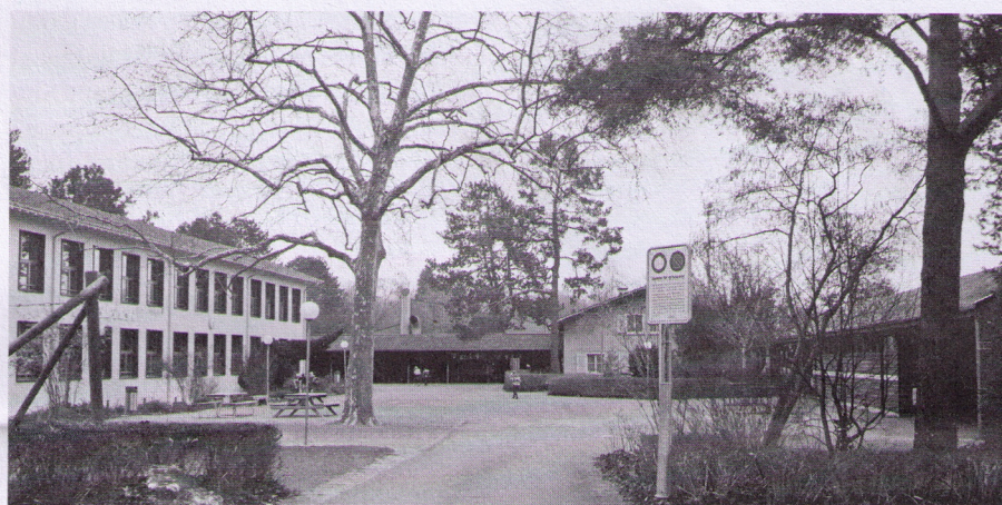
Eine Erweiterung der Schulanlage Breite ist dringend nötig: In diesem Punkt herrscht Einigkeit
