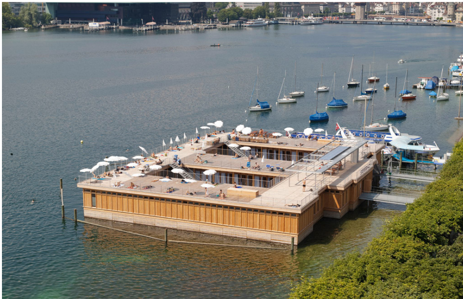
Seebadi Luzern, Gesamterneuerung 2010, Bosshard/Luchsinger, Architekten Luzern
