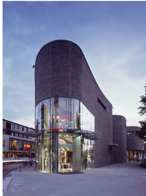
Projekt von Riehle + Assoziierte mit den Innenarchitekten RaiserLopesDesigners, Bauherr ist die Holy AG, an: Geschäftshäuser an der Erms in Metzgingen, prämiert bei unserem Auszeichnungsverfahren „Beispielhaftes Bauen Landkreis Reutlingen 2001-2008“ (Fotograf: Wolfram Janzer)
