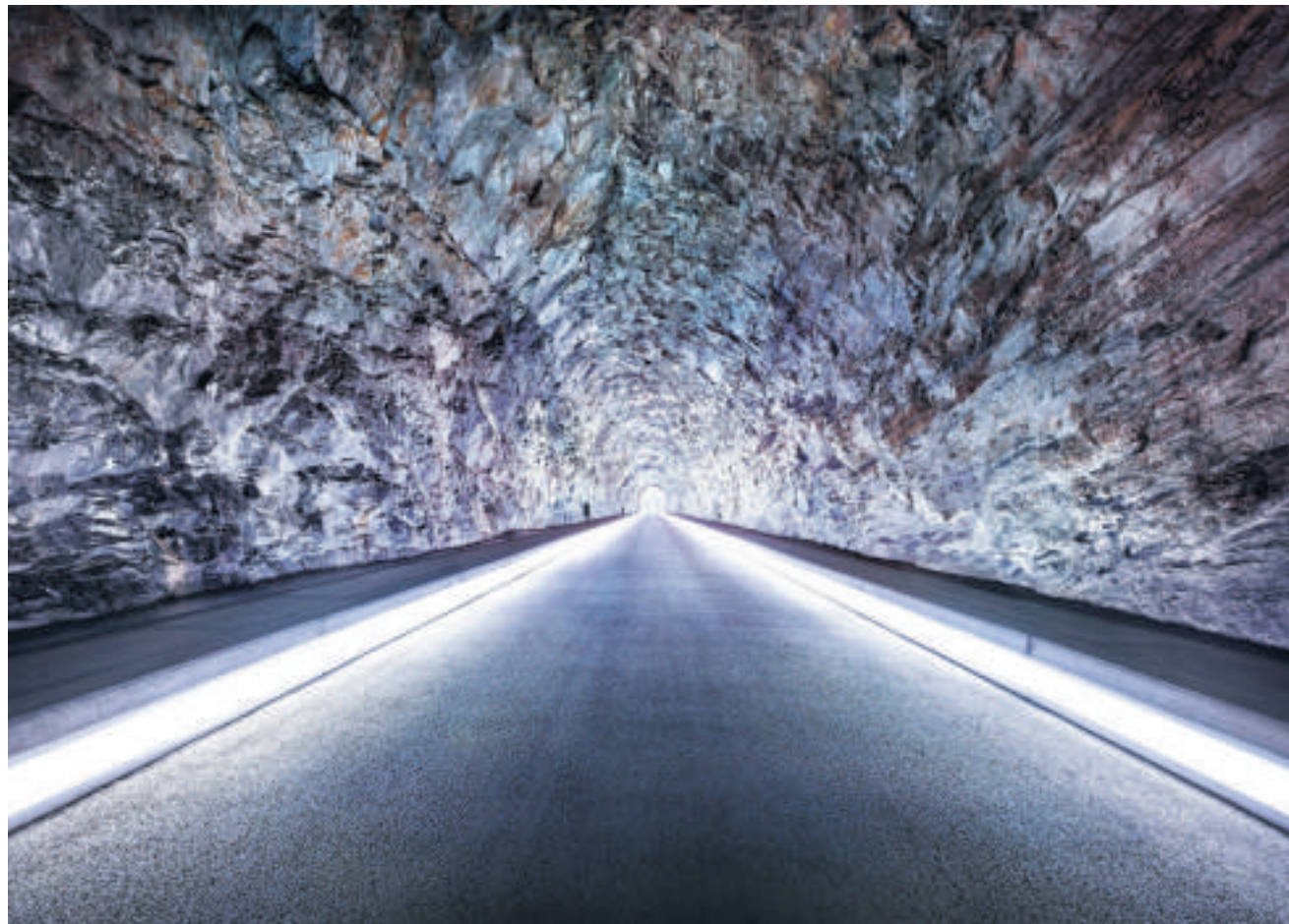
Zugangsstollen zur Kavernenzentrale Ferrera am Hinterrhein, fertiggestellt im Jahr 1963.
