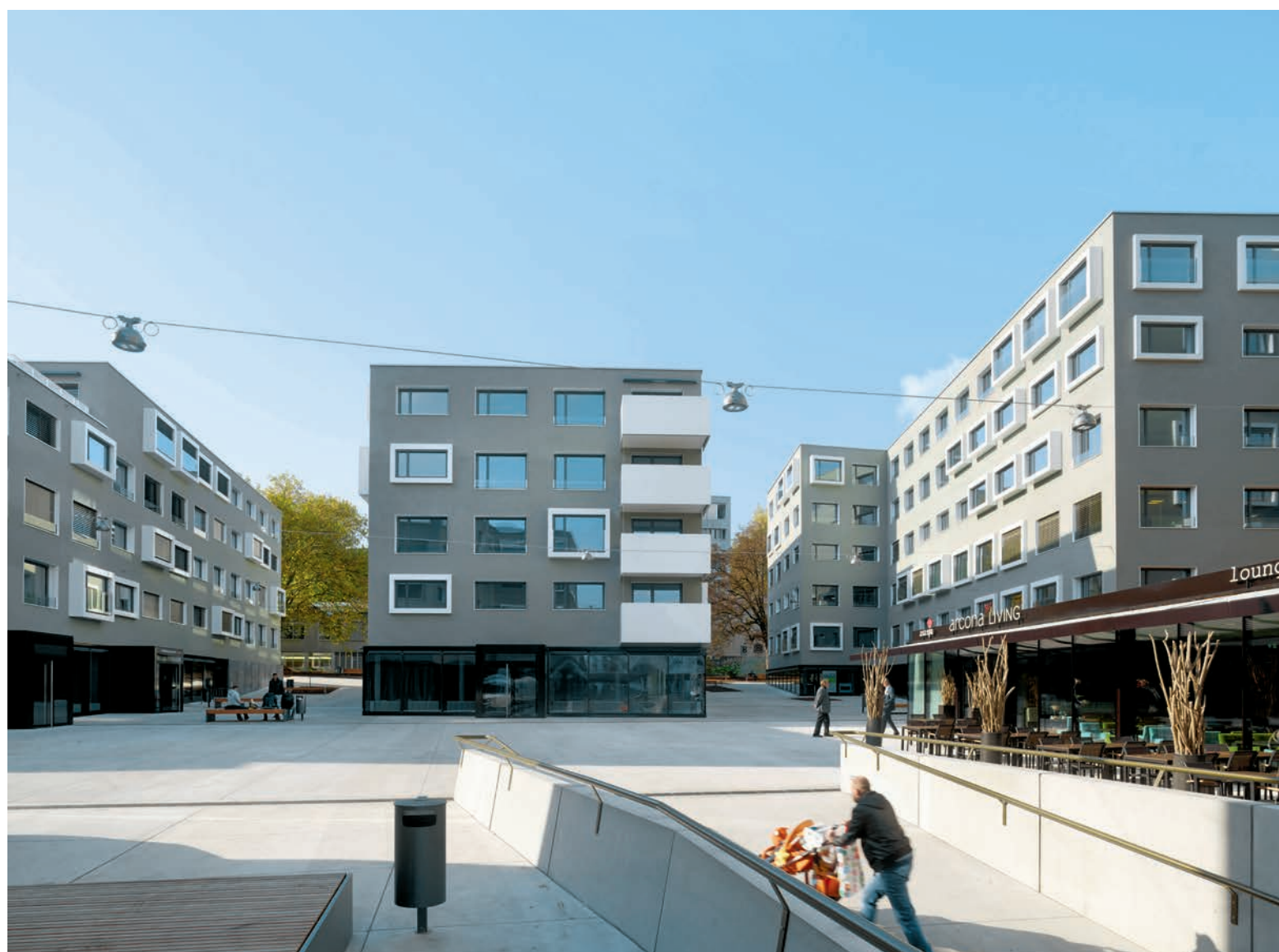
Anstelle der einstigen Stadtallmend umringen fünf Bauten mit öffentlich genutzten Erdgeschossen den Bleicheplatz als Zentrum des neuen Schaffhauser Stadtquartiers.
