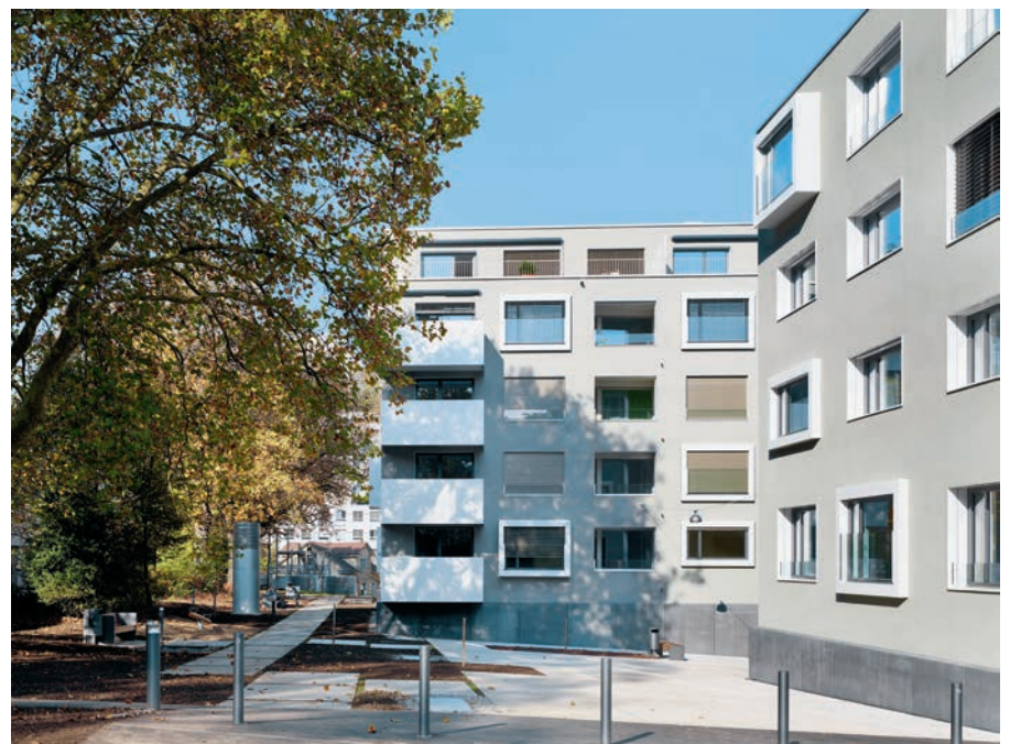
Wie zum Bleichen ausgelegte Tücher löst sich der Stadtplatz rückwärtig in Steinflächen auf.
