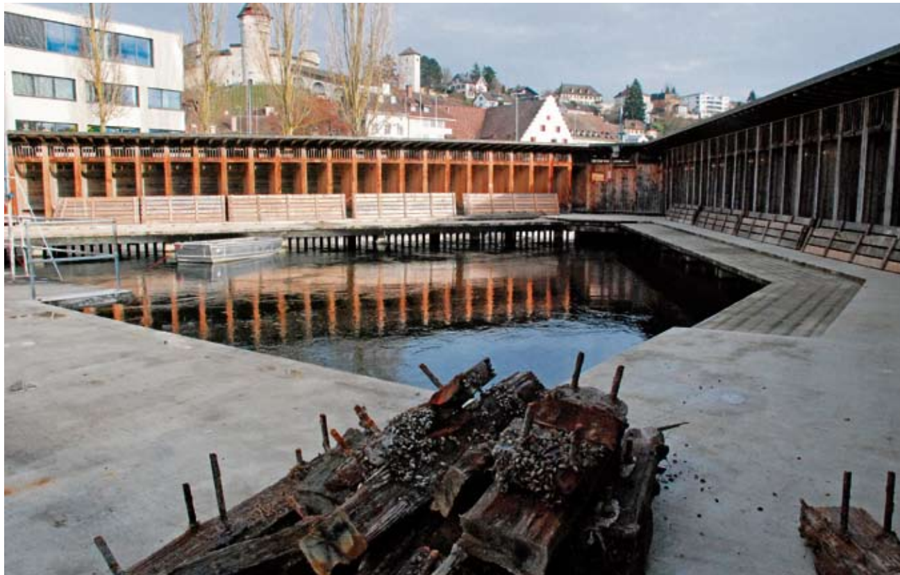
Situation gestern: Die letzten Überreste des Bretterbodens liegen noch beim «Spitz» der Rhybadi, der nun nur noch für Schwimmer geeignet ist, denn die Wassertiefe ist jener im langen Schwimmerbecken vergleichbar.
