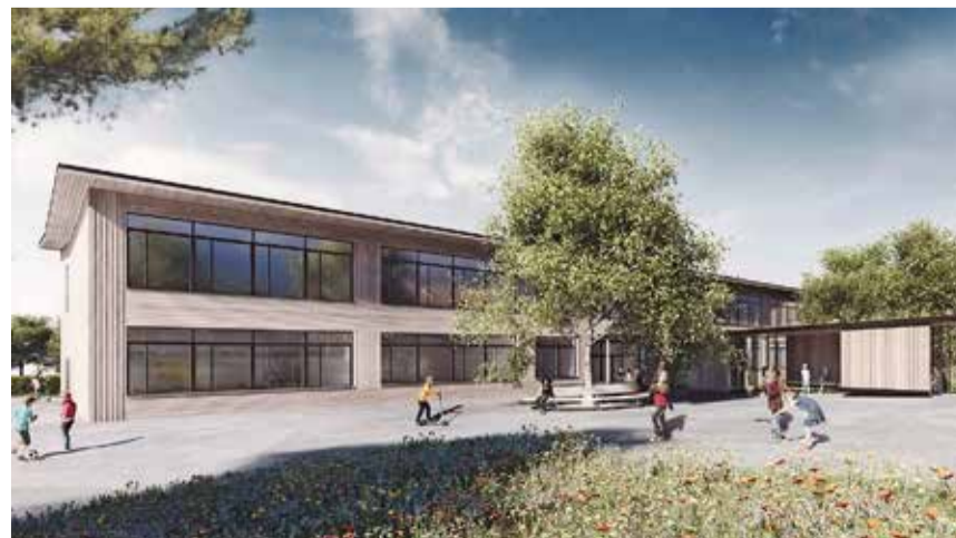
Das wichtigste der drei Gebäude des Projekts «SOL»: Der Schulhaus-Neubau soll aus vorfabrizierten Holzelementen erstellt werden.
