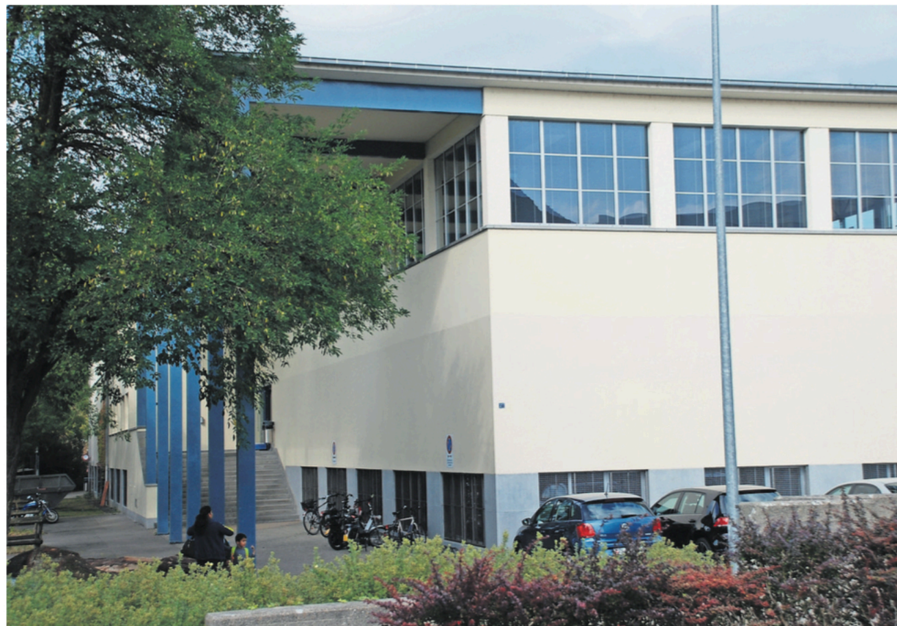
Die Turnhalle des Schulhauses Emmersberg mit ihren hohen Säulen als Zeitzeuge des modernistischen Bauens im Schaffhausen der Dreissigerjahre. Bild Tito Valchera
