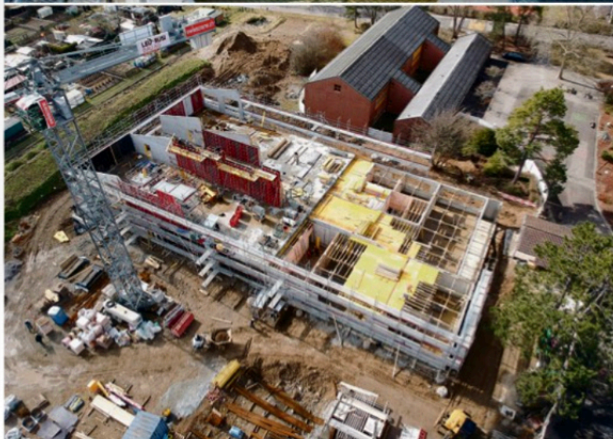
Die Schulanlage «Shed» auf der Breite ist in rund anderthalb Jahren gebaut worden.
