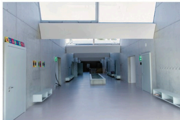
Das Sheddach der Schulanlage bringt viel Tageslicht in das Obergeschoss.
