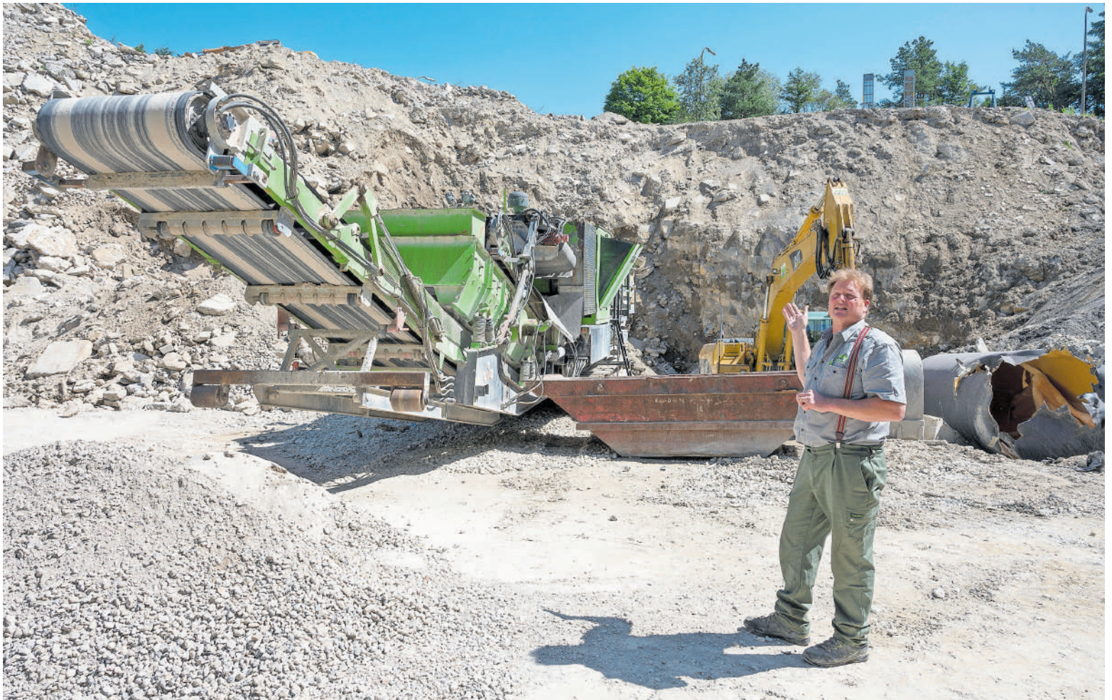
Bauunternehmer Andres Frei zeigt den sogenannten Brecher.
